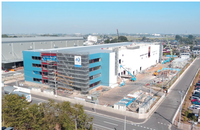
平成28年10月15日現在 建設中の工場外観
