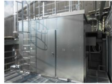
【効率の高いボイラー設備】
