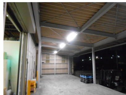
【高効率の蛍光灯（Hf）へ入れ替え】
