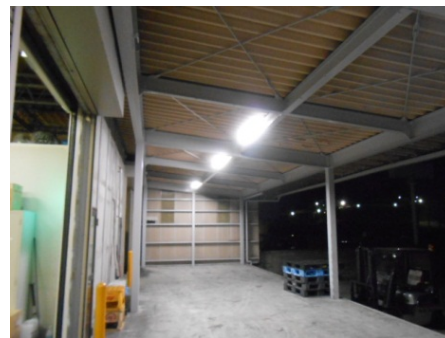
【高効率の蛍光灯（Hf）へ入れ替え】
