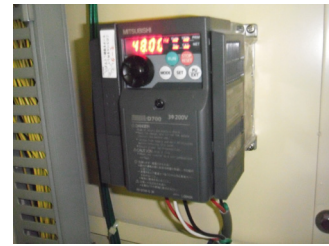
【給排気ファンのインバーター制御】
