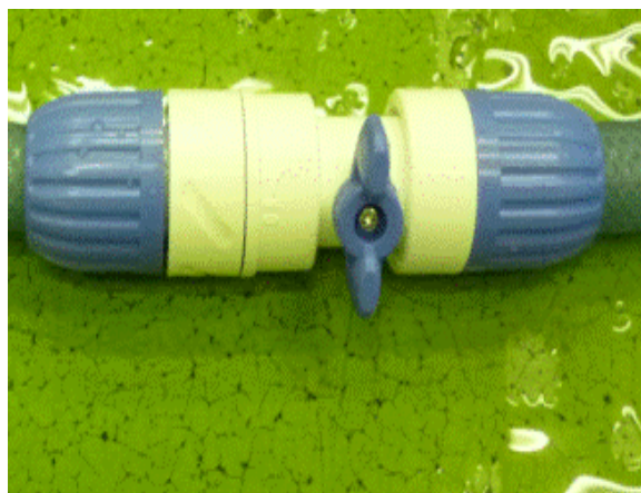
洗浄用ホースへの節水バルブ取付【2社共通】
