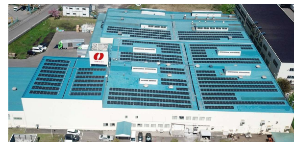
(株)函館なとり 太陽光発電設備 2024年3月稼働
