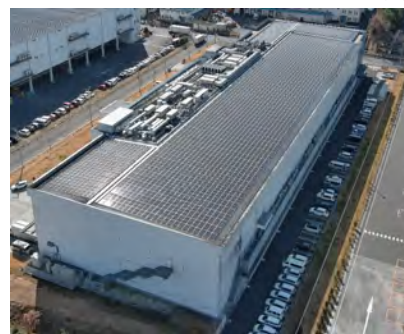
埼玉第二工場 (チーズファクトリー) 太陽光発電設備 2022年4月稼働
