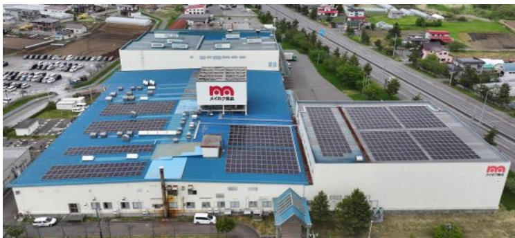
工場屋根に818枚の太陽光パネルを設置
