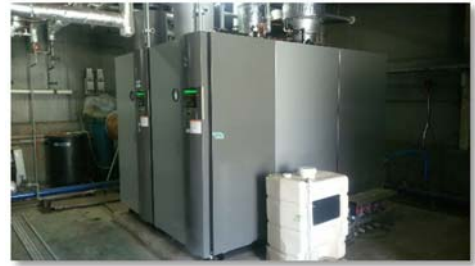
【新型の重油焼きボイラー】
